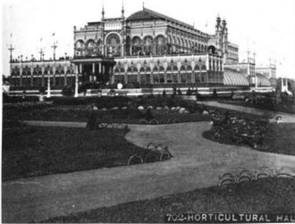
写真3 園芸館の外観。
