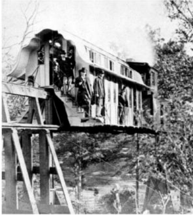
写真4 万博会場内の移動に考案された史上初のリロイ・ストーン式モノレール。農業館と園芸館を結ぶ170ヤード（155メートル）を走行した。（ステレオビュー）
