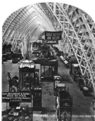
写真2 農業館の内部。
