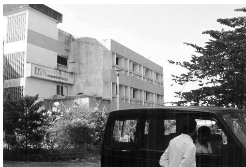
図3 ゴア、改装中のSTPIビル
